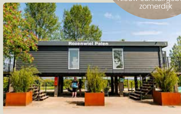
Nieuw sanitairgebouw zomerdijk
